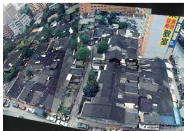
大安新村拆除前之樣貌
